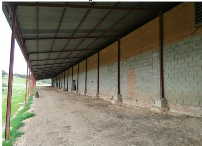
La capacidad total de la nave para albergar animales, en caso de emergencia sanitaria, es de 655. Para que se pudiera dar esta circunstancia, la estructura básica de la nave, constituida por cubierta y pórticos metálicos, debe ser previamente acondicionada mediante las siguientes actuaciones:
